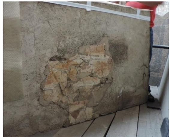
*Figura 4. Stato di conservazione del supporto cementizio*
